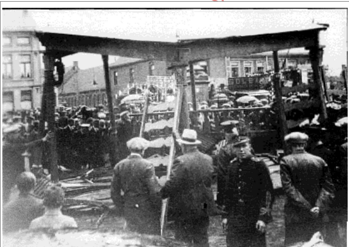
Tijdens de installatie van burgemeester Callewaert, komt een fiks onweder de feestvreugde bederven. Veel mensen gaan schuilen op de bouwvallige kiosk die onder de overlast bezwijkt.
