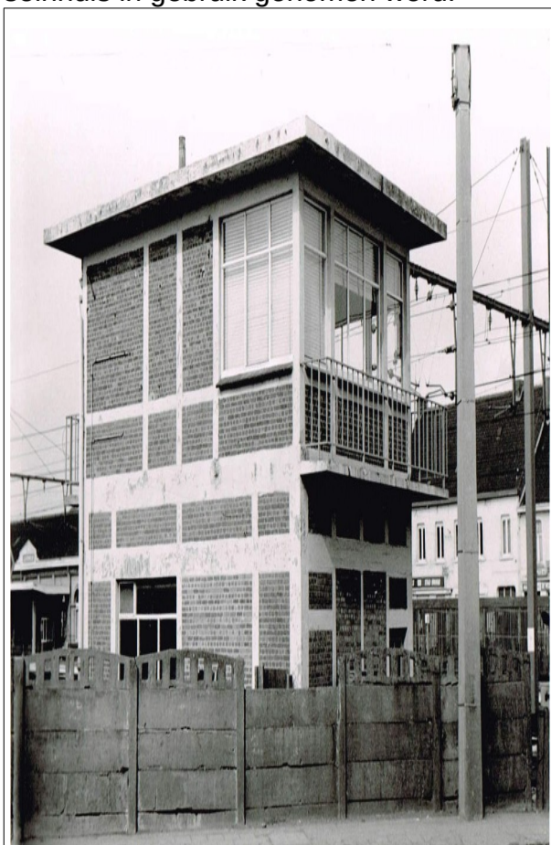
Seinhuis 66/52 ten westen van de spooroverweg.
