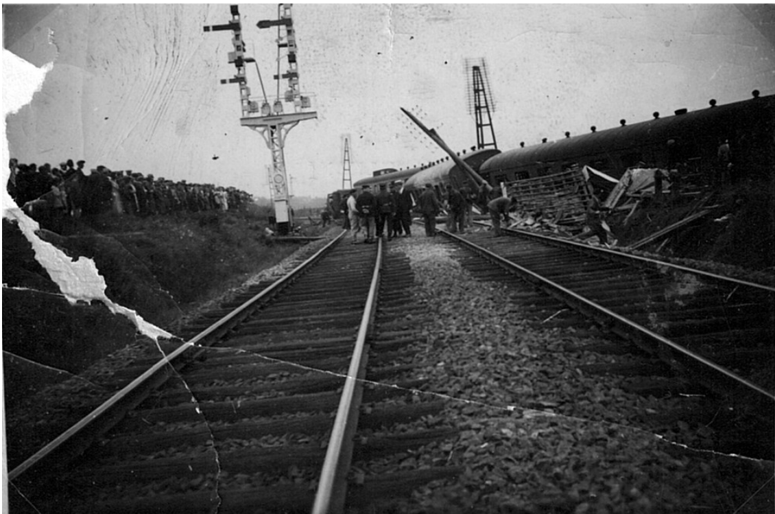
Algemeen zicht van de ravage; foto genomen vanop het spoor Kortrijk - Brugge, richting station Lichtervelde. Bemerkt de talrijk opgekomen ramptoeristen-avant-la-lettre.
