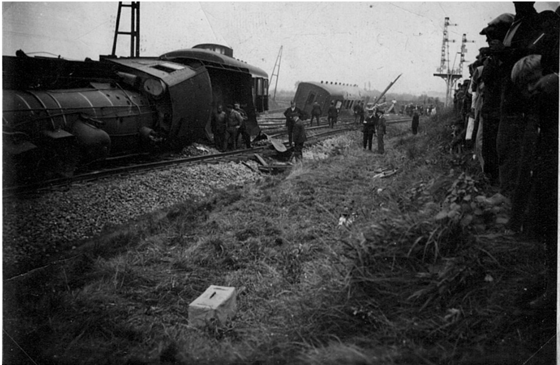
Op de voorgrond de gekantelde locomotief, op de achtergrond het tweede rijtuig dat het barreelwachtershuisje en een telegraafpaal ramde.
