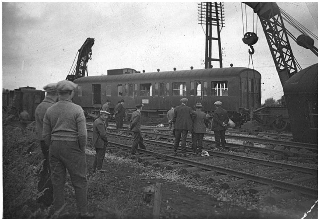
Twee kranen plaatsen de eerste wagon terug op de sporen.
