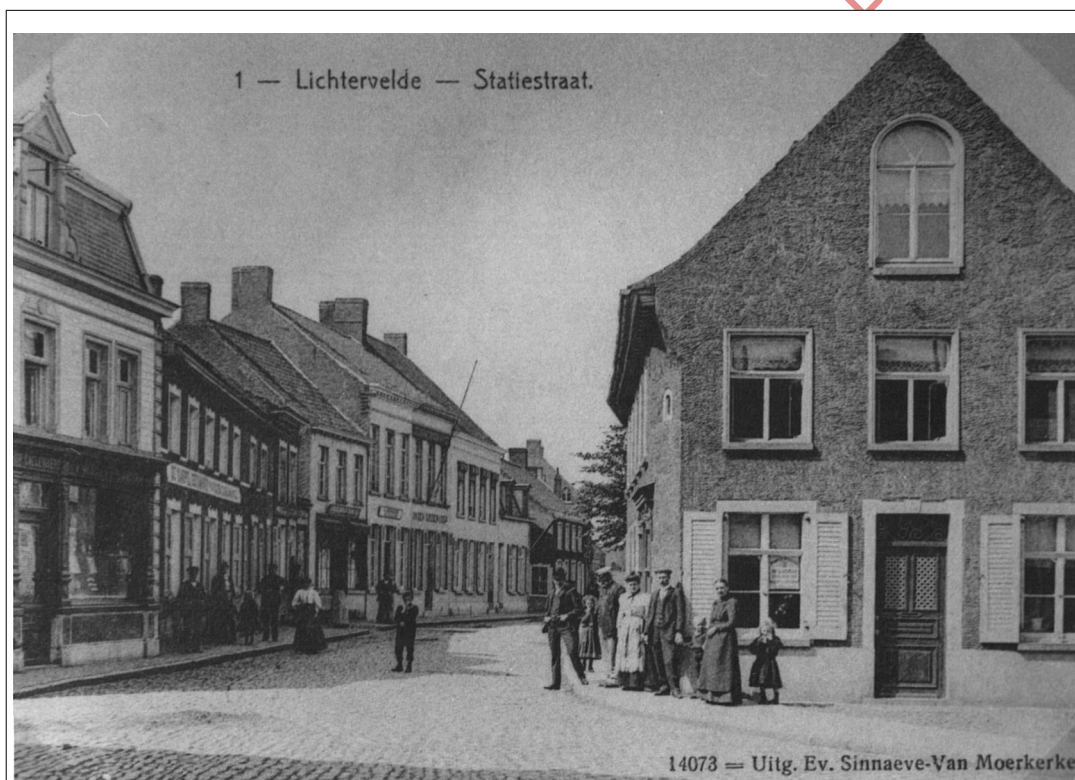
Foto 1: Dit beeld werd genomen waar nu de Astridlaan begint. De huizen rechts werden afgebroken bij het aanleggen van de Astridlaan omstreeks 1935. Helemaal links merk je de ijzeren pomp van het "Gildhof". Het huis erachter is de accordeonfabriek van Felix Callewaert. ernaast was café "De Karpel", nu bakkerij Volcke. Let op het opschrift "In den goedenkoop" bij L. Govaere en op de reclameaffiche van een spaarkas aan het raam.
