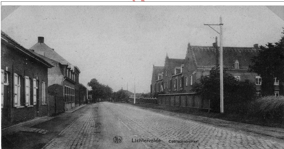
Foto 1: Deze foto dateert van voor 1937 toen het mansardedak van het gesticht vervangen werd door een plat dak. Bemerkt ook dat de Koolskampstraat nog in kalsijde ligt. De schutstoren van de familie Debaillie is er nog niet op te zien.
