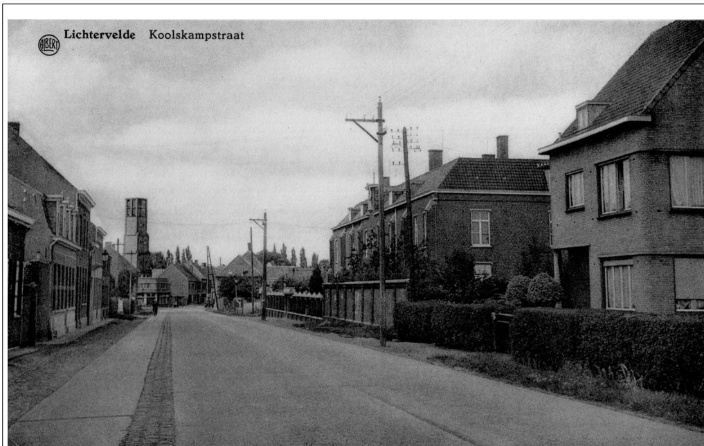
Foto 2: Het dak van het Rosaliagesticht is veranderd. De Koolskampstraat ligt al in beton en de schutterstoren van de familie Debaillie is al opgedoken.
