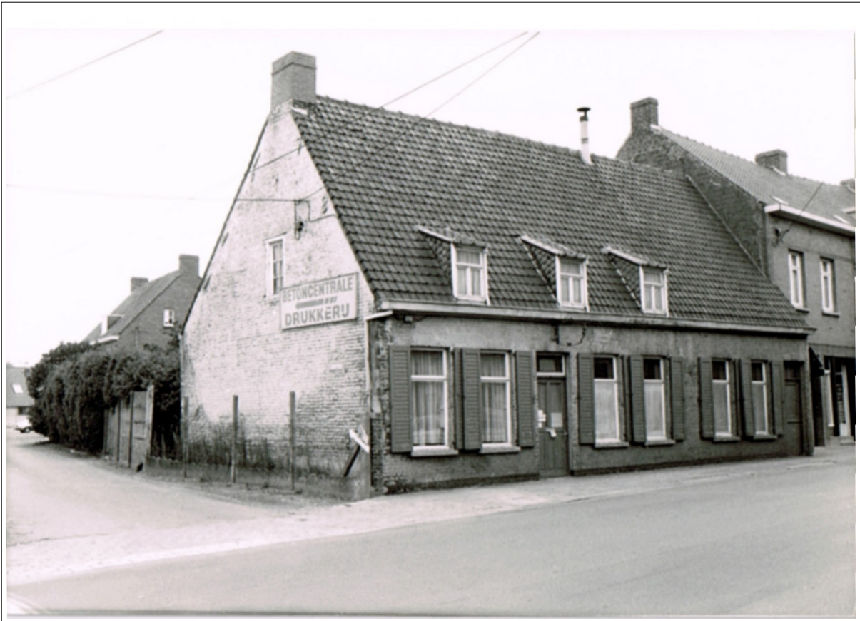
Het "BAZAARKE" van de familie VERBEKE, waar men van alles en nog wat kon krijgen. Gebouwd in 1870 (of was het 1780?) zoals de ankers in de zijgevel laten vermoeden.
