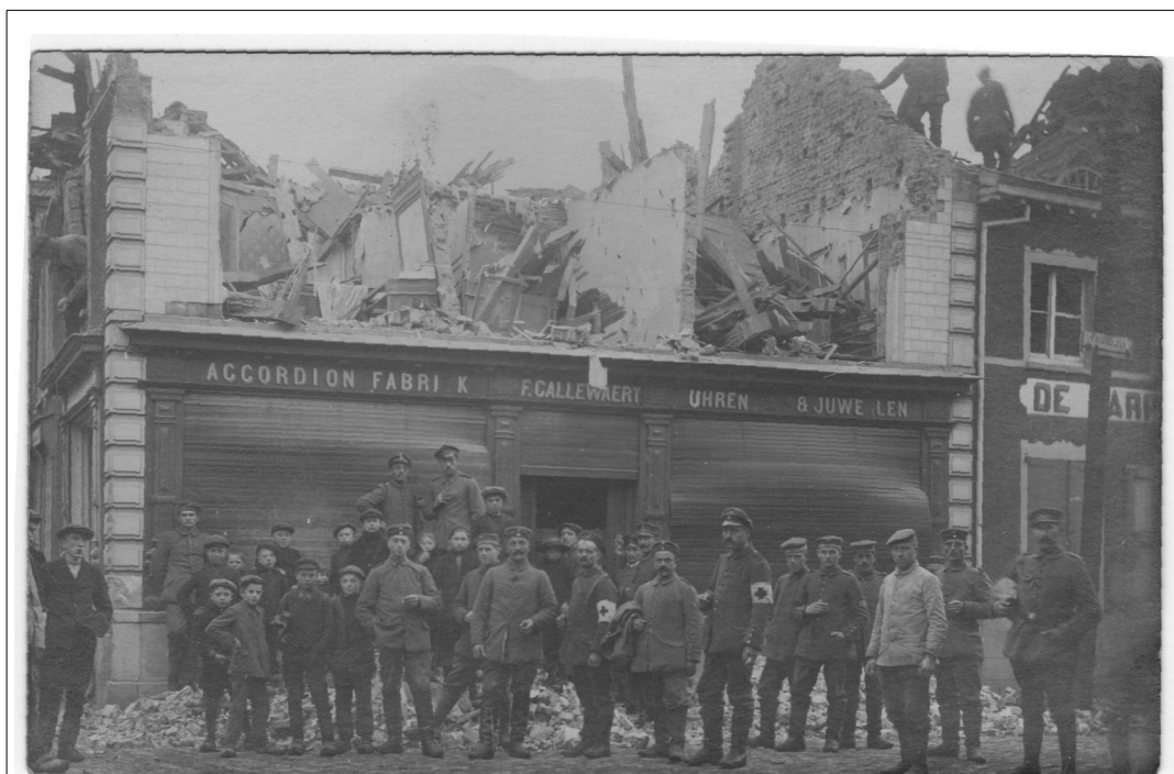
De zwaar getroffen woning van Felix Callewaert aan de Stationsstraat. Let op het bordje aan de paal rechts met het Duitse opschrift "Feldlazaret". Daarmee werd waarschijnlijk het Oude Manhuis in de Stationsstraat bedoeld.
